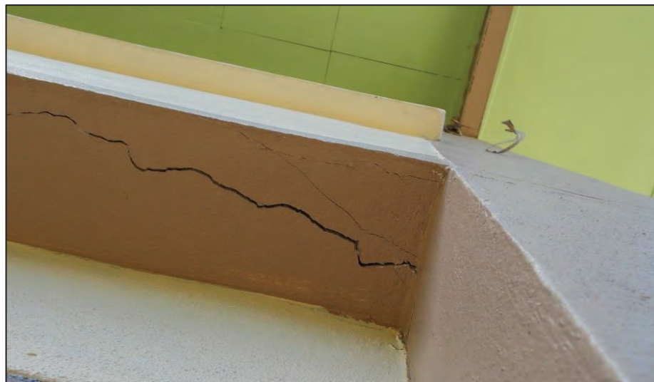
รูปที่ 4 ลักษณะของอาคารที่มีความเสียหายระดับสีเหลือง
